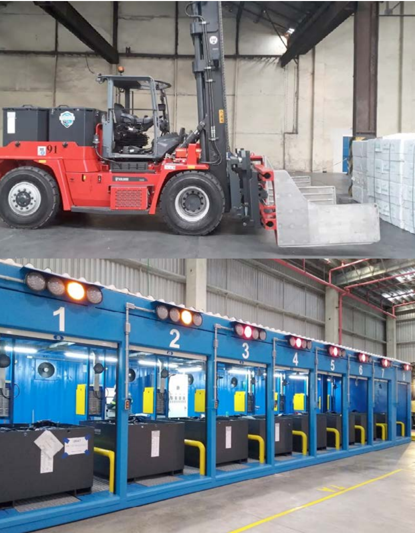
Sagres: grúa horquilla eléctrica y sus casas de baterías. Electric forklifts and battery houses
